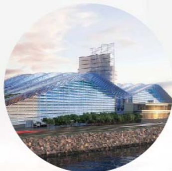
香港环保署 稔湾污泥焚化 处理设施工程
