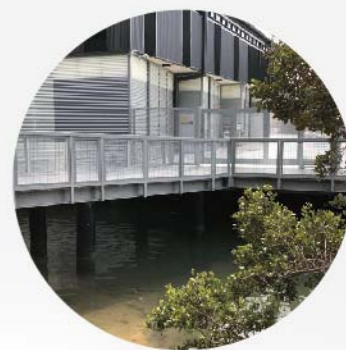
澳大利亚悉尼大学 游艇码头重建工程
