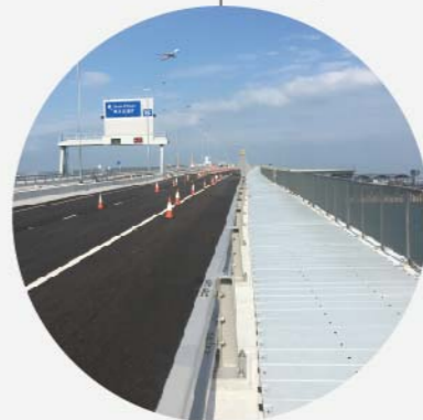
香港路政署 港珠澳大桥香港段 检修栈道桥板工程
