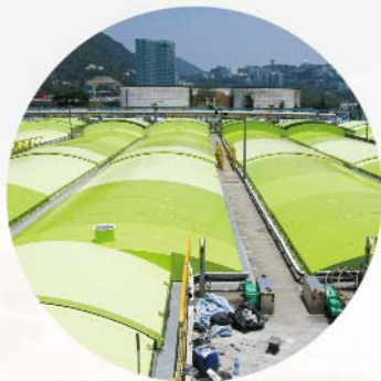
香港渠务署 沙田污水处理厂 初级沉淀池覆盖工程
