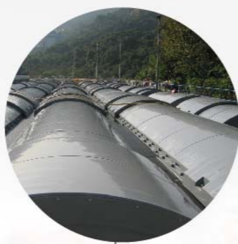
香港水务署 沙田滤水厂 过滤池覆盖工程
